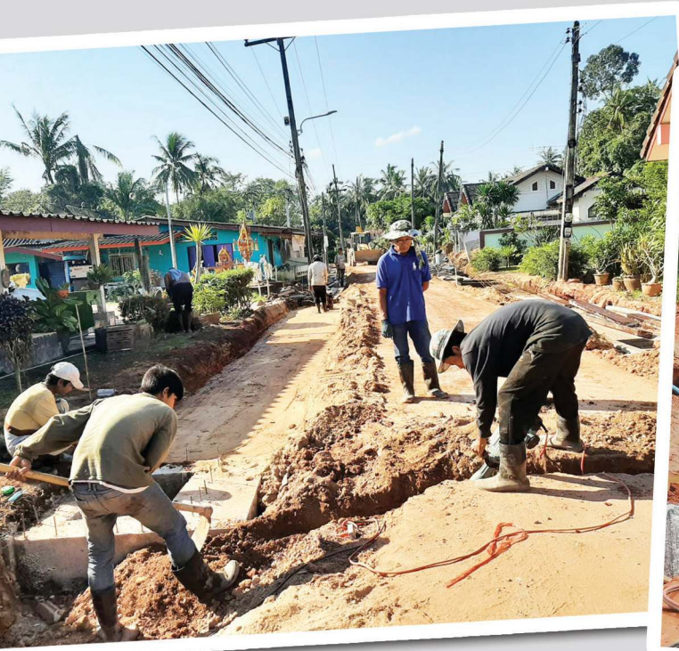
นายประเสริฐ สุขคะโต ผู้อำนวยการสำนักการช่าง ร่วมกับเจ้าหน้าที่ที่เกี่ยวข้อง ได้ลงพื้นที่ตรวจสอบติดตามงานโครงการก่อสร้างท่อระบายน้ำและฝิวจราจรคอนกรีตเสริมเหล็กถนนประจักษ์รัฐเชื่อมต่อกับถนนกาญจนาวิถี ซอย ๓๗
