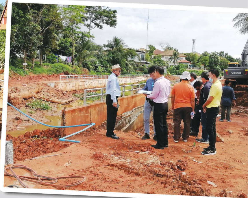
นายประเสริฐ สุขคะโต ผู้อำนวยการสำนักการช่าง ร่วมกับ นายกมล พดพิพฤกษ์ โยธาธิการและผังเมืองจังหวัดสุราษฎร์ธานี ได้ลงพื้นที่ตรวจสอบติดตามงานโครงการก่อสร้างระบบป้องกันน้ำท่วมภายในเขตชุมชน เมืองสุราษฎร์ธานี (ระยะที่ ๒) แนวคลองบางใหญ่
