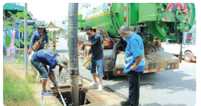
นายสุพิง แซ่ห่อง รองนายกเทศมนตรีนครสุราษฎร์ธานี ลงพื้นที่ดูการ ดำเนินงานของเจ้าหน้าที่ส่วนช่างสุขาภิบาล สำนักงานการช่าง ทำการดูแลติดตั้งท่อ บริเวณหมู่บ้านการเคหะ ชุมชนการเคหะ เพื่อทำความสะอาดท่อระบาย ป้องกันการเกิดโรคต่างๆ พร้อมป้องกันปัญหาการเกิดน้ำท่วมฉับพลัน ในเบื้องต้น กรณีเกิดฝนตกหนัก
