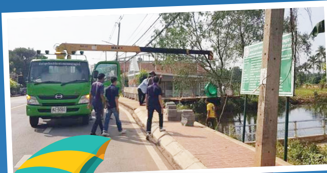
ส่วนช่างสุขาภิบาลได้ทดลองติดตั้งตาข่ายดักขยะที่บริเวณปากท่อ พร้อมยกเก็บขยะเพื่อนำไปทิ้ง
