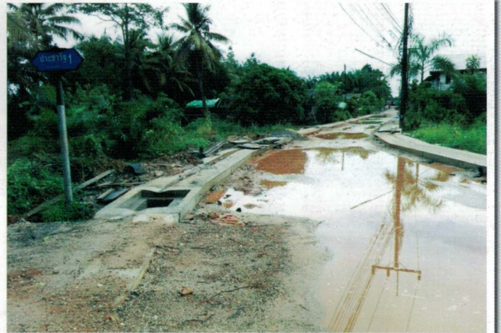
ตรวจสอบโครงการที่กำลังดำเนินการ รับผิดชอบต่อปัญหา และหาแนวทางแก้ไข เพื่อให้ประชาชนได้รับความสะดวกที่สุด ขณะที่กำลังดำเนินการก่อสร้าง
