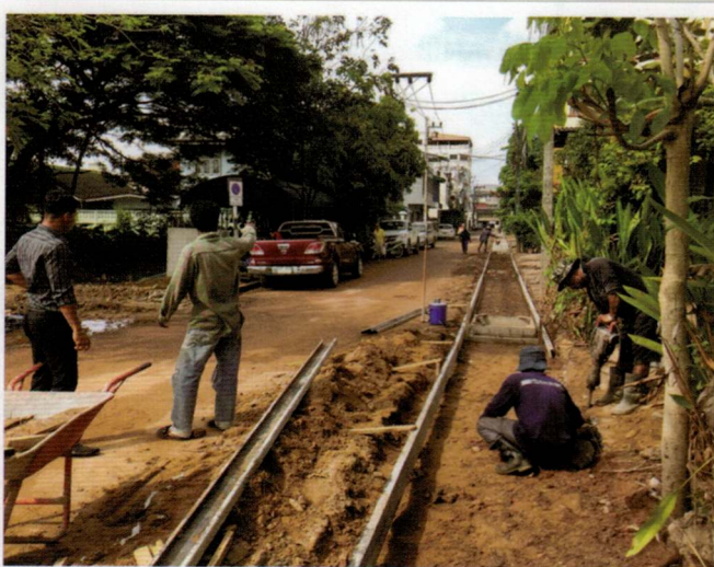
การควบคุม ตรวจสอบ งานก่อสร้างท่อระบายน้ำ งานรางวี ถนนชนเกษม ซอย 22
