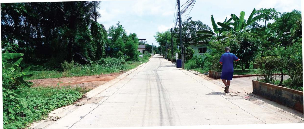
โครงการก่อสร้างท่อระบายน้ำและฝิวจราจร ถนนกาญจนาวิถี ซอย 22
