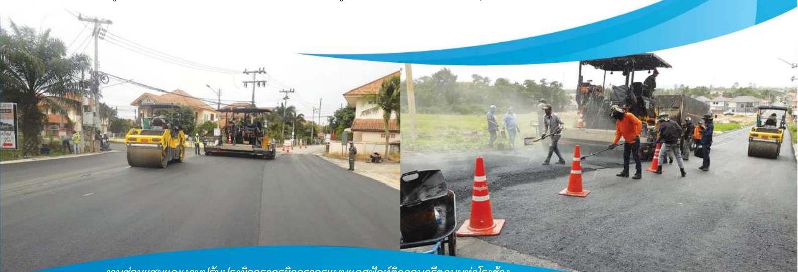
งานซ่อมแซมและงานปรับปรุงผิวจราจรผิวจราจรแบบแอสฟัลต์ติกคอนกรีตถนนท่าโรงช้าง และซอยแยกต่างๆ และถนนชนเกษม ซอย 43,47,49 โดยงานสาธารณูปโภค ส่วนการโยธา สำนักงานช่าง
