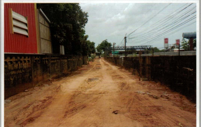
โครงการวางท่อระบายน้ำและผิวจราจร คสล. ถนนบางกุ่ม 1 (ซอยข้างธนาคอนกรีต)
