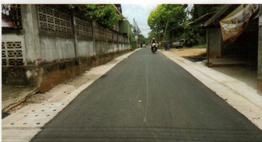
โครงการปรับปรุงผิวจราจรแบบแอสฟัลท์ติกคอนกรีตถนนกาญจนวิถีสอย 23
