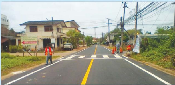
งานปรับปรุงผิวจราจรแบบแอสฟัลต์ติกคอนกรีต และตีเส้นจราจรถนนเมืองใหม่
